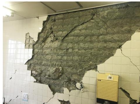
内壁が剥離し鉄柱がむき出しになっている箇所
