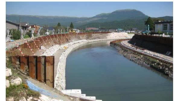
■内牧の河川改修工事。鋼矢板（連続した鉄骨）堤防上端まで打ち込む。
