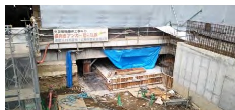
(地下を掘って免震装置を設置)
