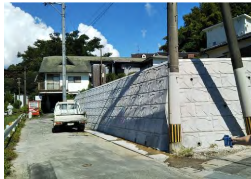
(抑止杭や地盤改良で復旧した池田1丁目)
