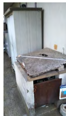
(左) すり切れた畳 (下左) 壊れた雨どい (下中) ブヨブヨの台所床 (下右) 屋根の割れたガスボンベ庫
