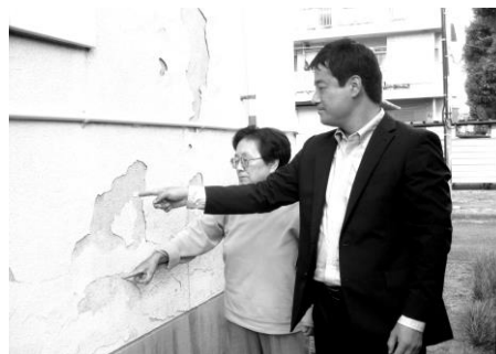
▼はがれ落ちた外壁塗装
