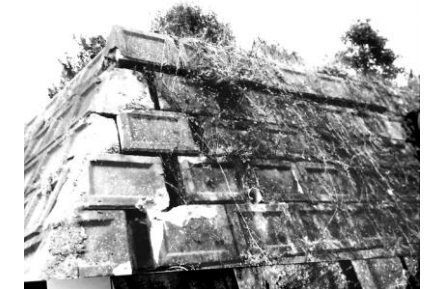
■バックリと大きく口を開けた宅地擁壁。発災から2年以上たった今でも手付かずのまま。（北区・清水岩倉）
