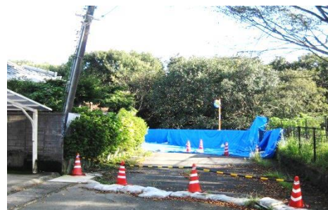
斜面に面した道路。地割れが発生し、崩落の危険が発生しています。(昨年10月撮影)
