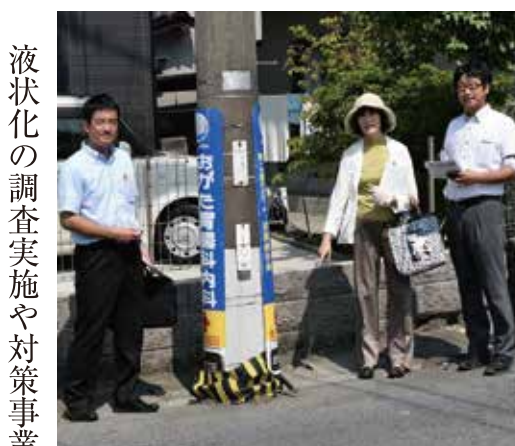
電柱が1m以上、地中にもぐり込んでいます。
