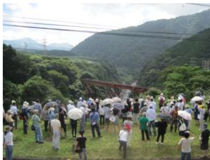
立野ダムが建設されようとしている立野峡谷 (第1回現地調査 2014年8月17日)
